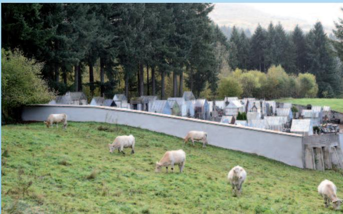
Des travaux de consolidation et de protection des murs Nord et Sud du cimetière communal ont été réalisés par l'entreprise CD Maçonnerie (Didier CHEZE) de Palladuc. Ils ont consisté au renforcement des murs concernés et à leur protection face aux intempéries par la pose d'une cadette.
