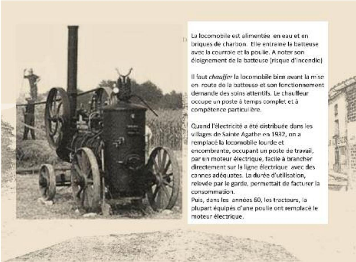
La locomobile est alimentée en eau et en briques de charbon. Elle entraîne la batteuse avec la courroie et la poulie. A noter son éloignement de la batteuse (risque d'incendie).
