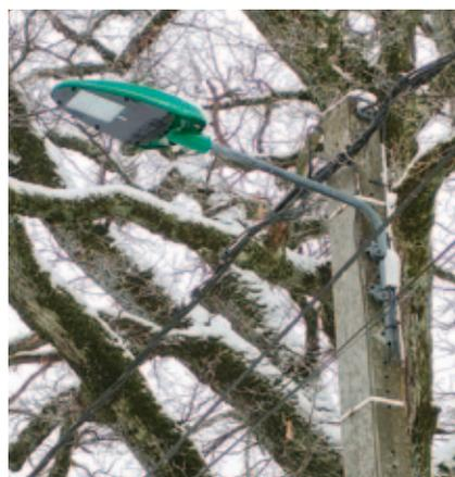
Les travaux de remplacement des ampoules de l'ensemble de l'Éclairage Public en LED avec variateur d'intensité ont été réalisés par l'entreprise Scie Puy-de-Dôme.
